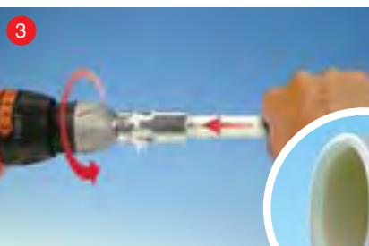
Производите калибровку трубы калибратором Henco Kalispeed. Вставьте калибровочное устройство правильно в трубу поверните таким образом, чтобы образовалась равномерная фаска с внутреннего и внешнего края трубы. Удалите все отходы
