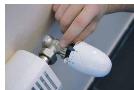
Закрутить никелированную круглую гайку и затем установить термостатическую головку
