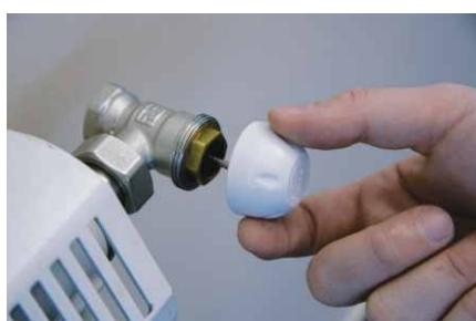
Снять колпачок или рукоятку с радиаторного вентиля
